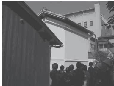
図1 『明月記』が保存されている冷泉家住宅の蔵（写真中央の白い建物）。
