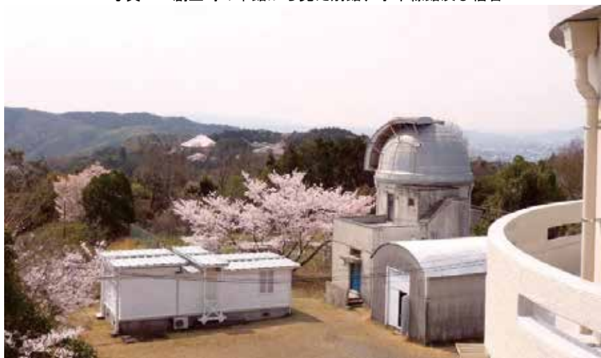
写真10 本館横の高架水槽の上から撮影した現状 (2020April.3)
