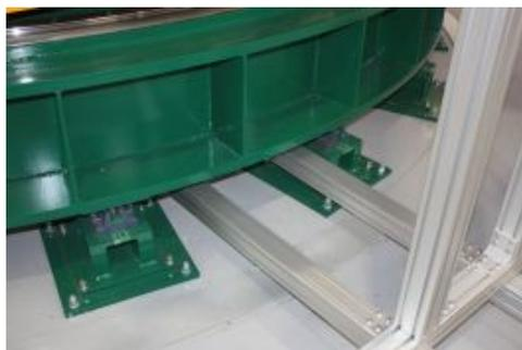
ベース部分の車輪は、Azレベリングブロックの9番と10番の間から入れる。これより左だとAz下のケーブルに車輪が当たるので良くない。また、上に人が乗っている状態で写真中央のアルミプレートを超えると、重量でプレートが曲がってしまうので、乗り込み前に前輪がここを越えている方がいい。
