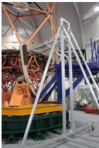
ナスミス大の手すりを3本外し、作業台上写真のように設置する。作業台の位置を調整する補助員が2名ほど居ることが望ましい。
