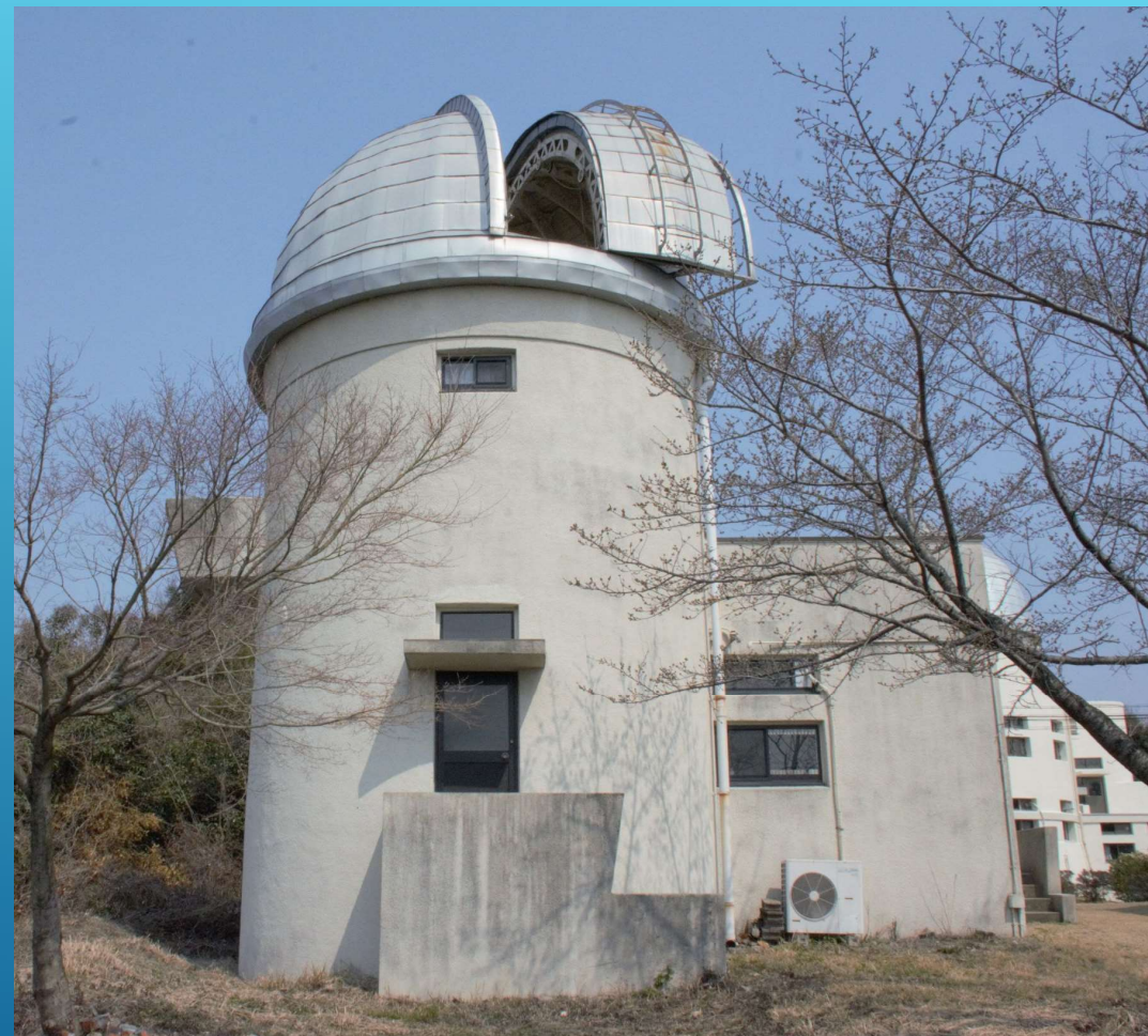
出入口前の台形の障壁
