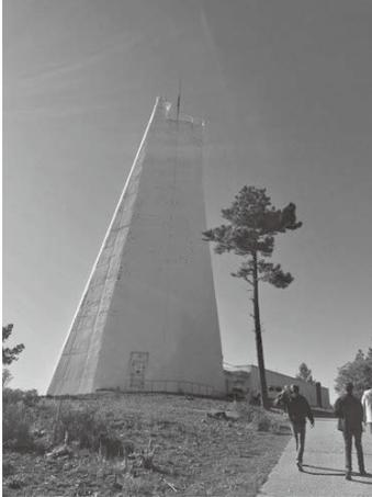
複数の望遠鏡を有するこの太陽天文台で、最も有名な望遠鏡は、1969年に完成した口径76cmのRichard B. Dunn Solar Telescope (DST)です(図4)。これは飛騨天文台のドームレス太陽望遠鏡(略称は同じDST)と非常によく似た構造で、地下69.5m地上41mの高さの垂直のタワー状の構造をしており、太陽の光を非常に細かくスペクトルに分け、太陽表面の磁場構造やガスの運動などを非常に詳細に観測することができます。完成から半世紀を経た今でも、装置の改良などにより、まだまだ現役で活躍しています。
