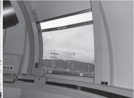
写真 2 : ドーム内部。窓には自作の折り畳み網戸を設置し、真夏日に小型のクーラと共に内部の室温を落としている
