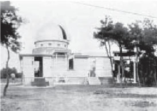
写真1: 創立当初の子午線館。中央の細い長窓が子午儀室。右側屋根全体が空いているのが経緯儀室
