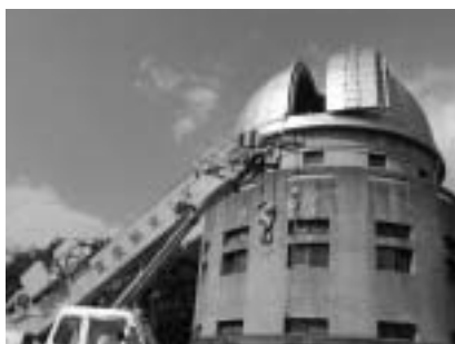
クレーンによるドームスリットからの搬入 (左) ・稼働状況 (右)
