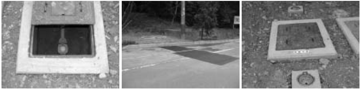
メーター取付工事終了
