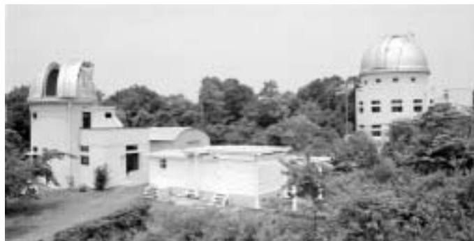
改修工事の終わった 別館・子午線館・本館(左より)
