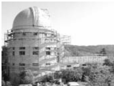
外壁塗装中の本館
