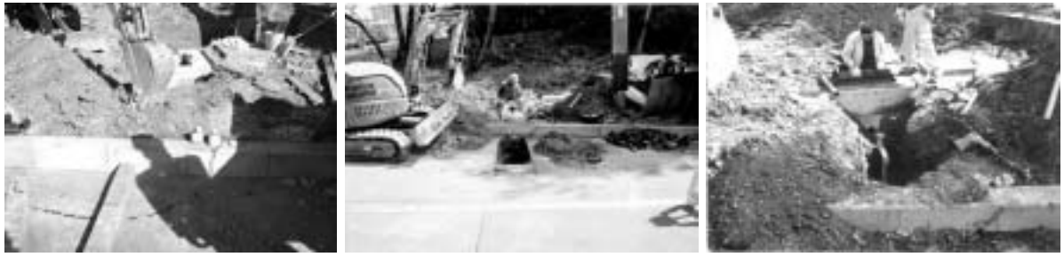
メーター取付工事の様子
