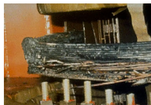
1989年のフレアで被害を受けた米NJ州の原発の変圧器
