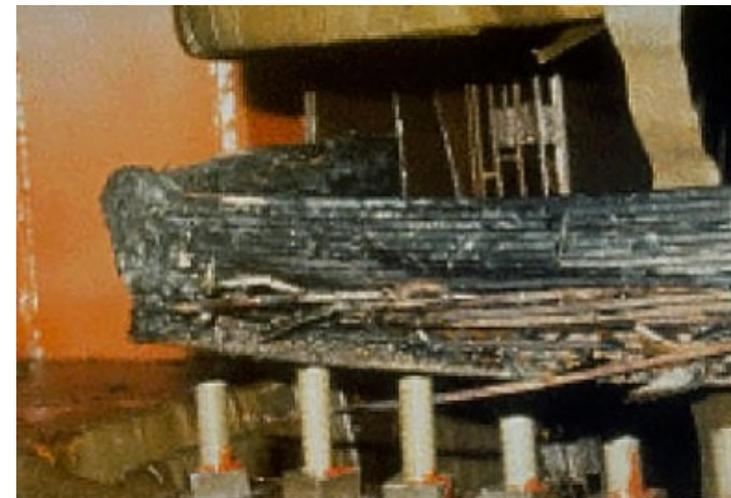
1989年のフレアで被害をうけた米NJ州の原発の変圧器
