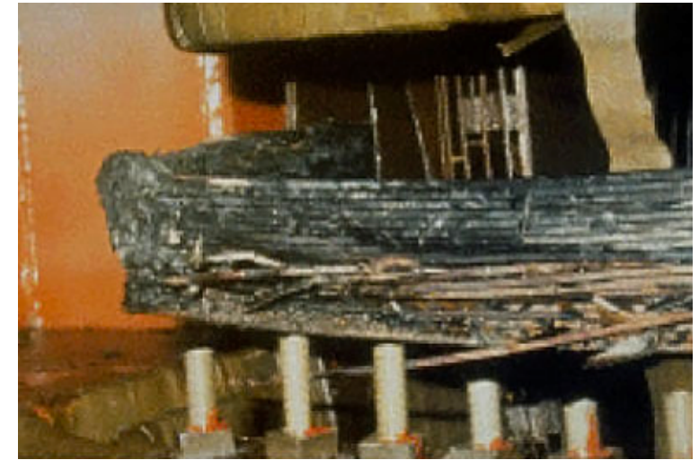
1989年のフレアで被害を受けた米NJ州の原発の変圧器
